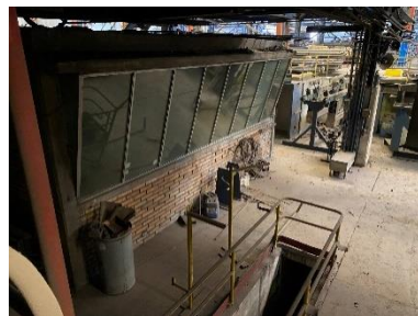
Fig. 22: Sala de control (pulpito).
