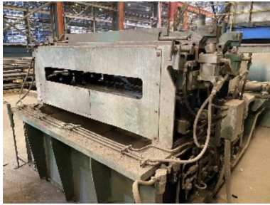
Fig. 30: Estrujadores estanque de agua
