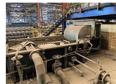
Fig. 29: Estanque de agua.
